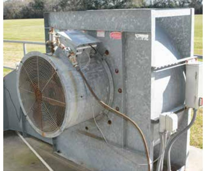
*Fig 8-2. Centrifugal fan.*
