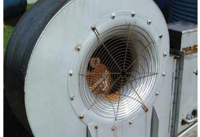
Fig 8-2 Centrifugal fan
